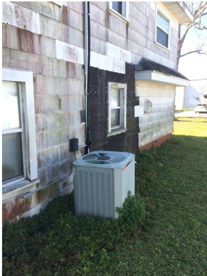
Asbestos Siding
