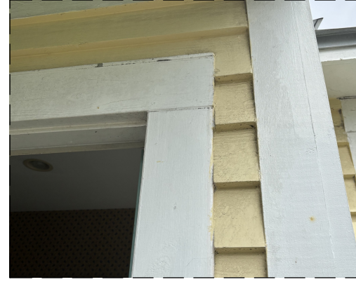
D2. EXISTING DOOR TRIM
